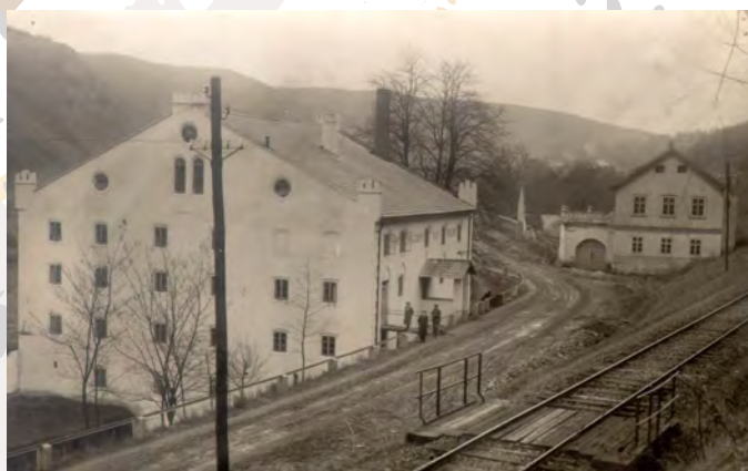
Velká budova musela ustoupit stavbě vranské přehrady, budova vpravo ale dodnes stojí. (foto archiv Arnošt Drozd).
